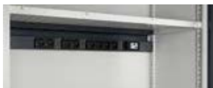
Applicazione canaletta elettrica sulla parte inferiore del piano-pannello forato
